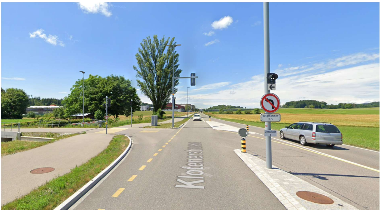
Abbildung 16: Mit Barriere gesicherte Busstrasse inkl. Busschleuse zwischen Kloten & Bassersdorf, Quelle: Google Streetview
