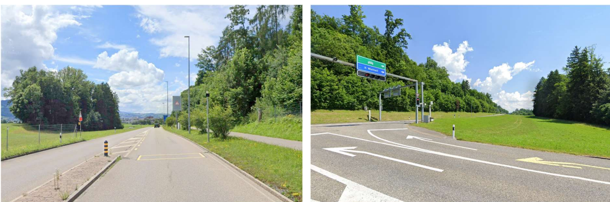
Abbildung 7: Referenz: elektronische Busspur Rickenstrasse zwischen A15 und Rapperswil-Jona; (links) Beginn der e-Busspur, (rechts) Blick auf die Rückführung im Knoten St. Dionys inkl. Bus-Priorisierung auf Uznacherstrasse
