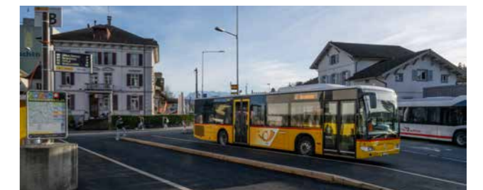
Der Bushub Sursee ist zurzeit im Bau. Während der Umbauzeit ist ein Haltestellenprovisorium in Betrieb.
