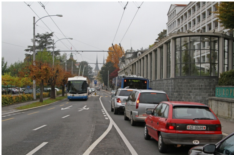
Abb. 16: Die Ausführung der Haltestelle Europe auf der Fahrbahn sichert dem Bus seine Position als Pulkführer.
