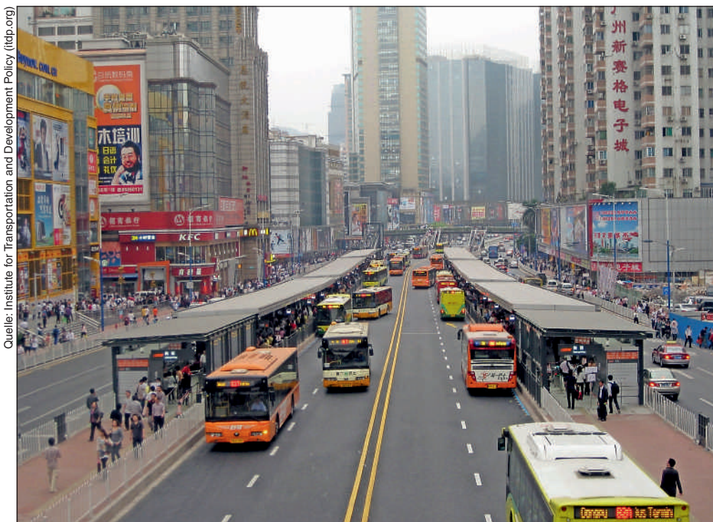
Abb. 1: Zweispurige Haltestellen als Element des BRT-Systems in Guangzhou.
